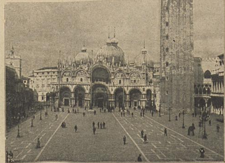
Der Campanile vor dem Einsturz.
