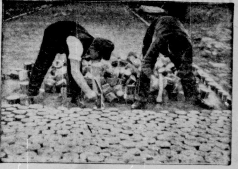
Auf einer Berliner Fernverkehrsstraße werden gegenwärtig Versuche mit einem Holzplaster gemacht, das sich in anderen Gegend bereits bewährt haben soll. Aus zahllosen gleichmäßig zerschnittenen runden Klotzen aus grünem Holz, das für Bauzwecke nicht brauchbar erscheint, wird eine Straßendecke geschaffen, die durch große Widerstandsfähigkeit und zugleich eine starke Elastizität bedingt Vorteile bieten soll.
