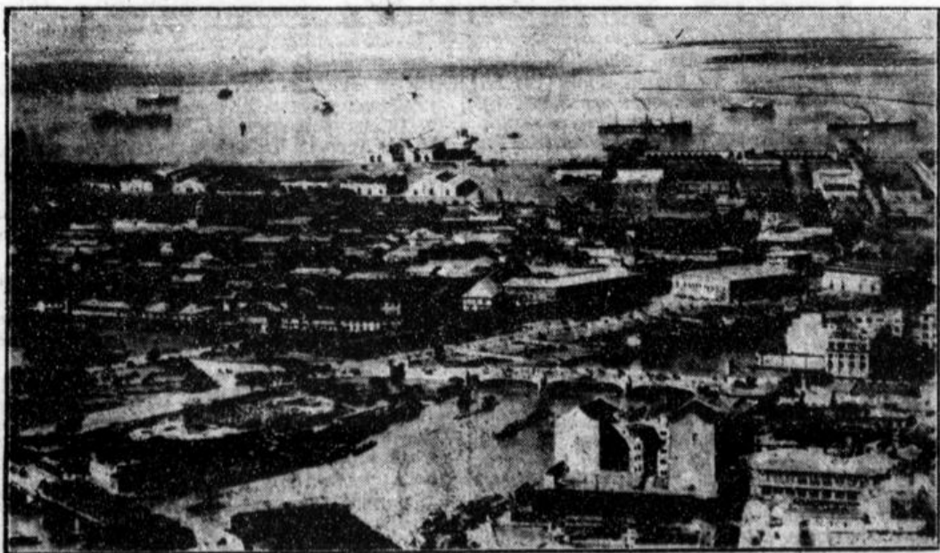
Unser Bild zeigt einen Teil der Hafenanlagen von Manila.
