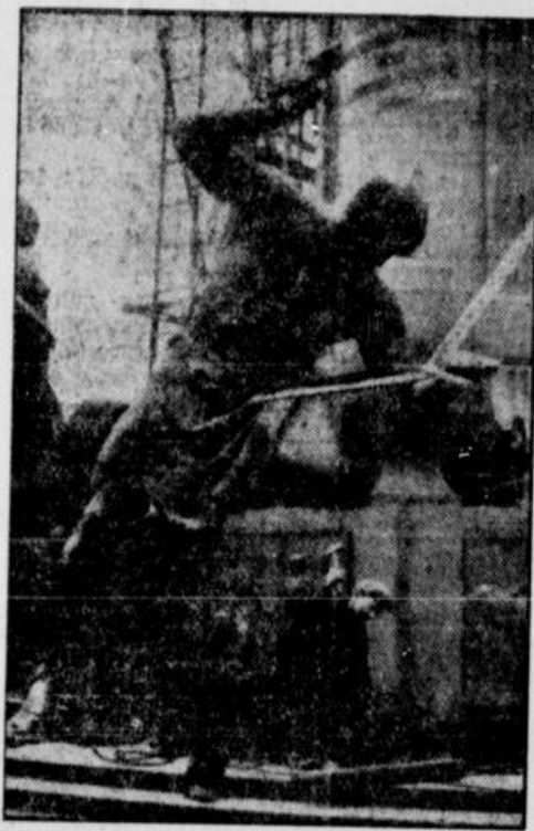
Ein hübsches Bild von den Arbeiten zur Umgestaltung der Reichshauptstadt. (Weltbild)
