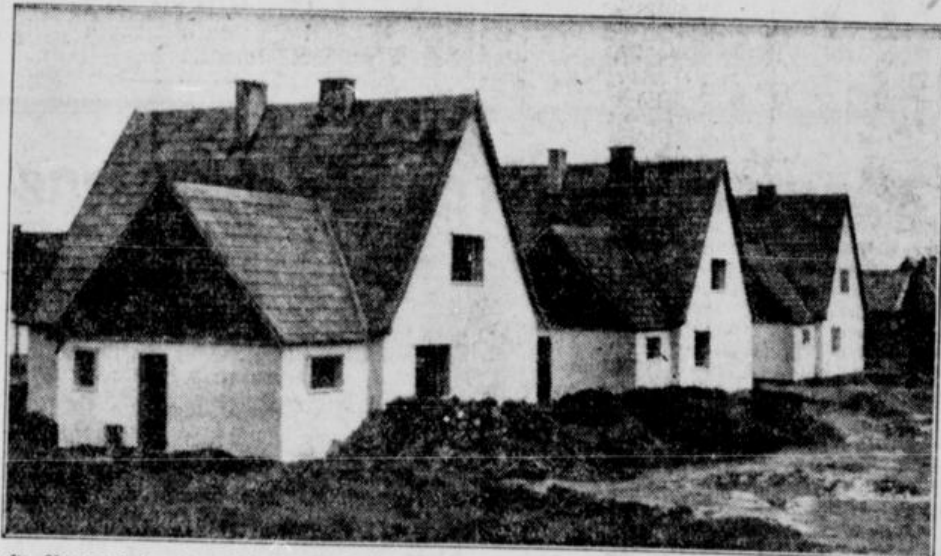
Das erste Bauvorhaben der SA-Dampferfiedlung, welche bei Leopoldau zur Ausführung kommt und rund 40 Stützstellen umfaßt, steht knapp vor seiner Vollendung. Nach einer äußerst kurzen Bauzeit von fast drei Monaten hat jetzt diese Stützstelle ihrer Bestimmung übergeben werden. Sie gibt ein sichtbares Zeugnis von dem Aufschwung, mit welchem der Nationalsozialismus die Volksgenossen der Dismark einer besseren Zukunft entgegenführt.
