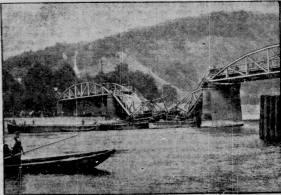
Der eingefürzte Brückenbogen.
