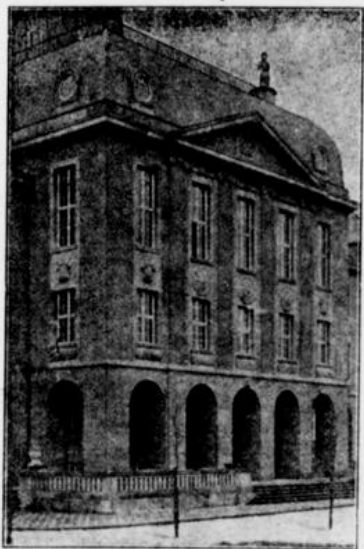
Mittelbau der Hauptfront.
