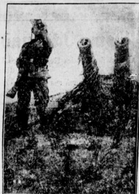
In Erwartung des Feindes. Auf Wache vor der Stellung der Küstenartillerie (PK-Engelmayr-Atlantic-M.)
