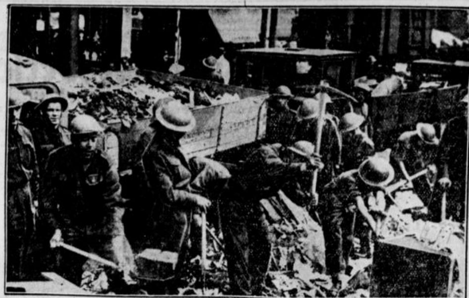
Die vernichtende Wirkung der deutschen Luftangriffe auf London hat in den letzten Wochen einen derartigen Umfang angenommen, daß die in London selbst zur Verfügung stehenden Hilfskräfte nicht mehr ausreichen, um die Schuttmassen abzutransportieren. Tausende von Pioniersoldaten wurden deshalb für die Aufräumarbeiten eingesetzt. London erntet, was seine Plutokraten gesät haben (Scherl-M.)
