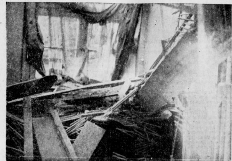
Bombeneinschlag in ein Schlafzimmer des Schwesternhauses
