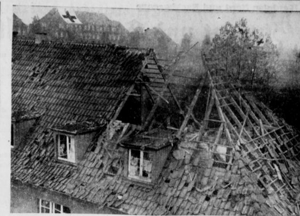
Ein in der Nähe der Universitätsklinik, die durch rote Kreuze gekennzeichnet ist, zerstörtes Schwesternhaus. Aufn. Hulsbusch (3)
