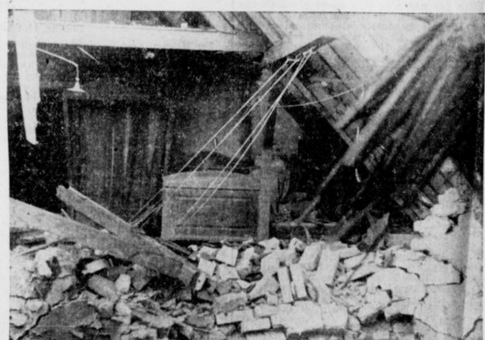
Ein zerstörtes Wohnzimmer im Schwesternhaus
