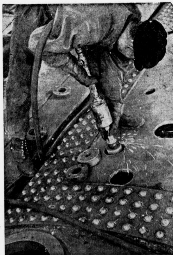
Unten: Unterseeboot-Bau ist präzise Werkmannsarbeit. Hier werden die in den Druckkörper eingeschnittenen Öffnungen ausgeschliffen.
