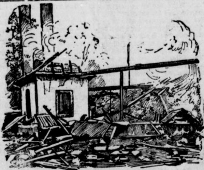
Inner der Trockenräume der Pulverfabrik in Sachsch.
