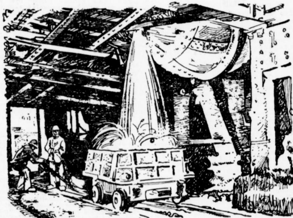
Nicht jeder dürfte aber wissen, daß erst durch das Thomasverfahren auch die Eisenindustrie in den Dienst des Ackerbaues gestellt wurde.
