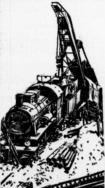
Hebung einer entgleiten Lokomotive. Auf dem Bahnhof Koblitz i. Schl. ist eine Schnellzug-Lokomotive entgleist und tief in die Abgrube gestürzt. Um die Lokomotive wieder auf die Gleise zu heben, mußte ein Riesenkran herbeigeschafft werden.
