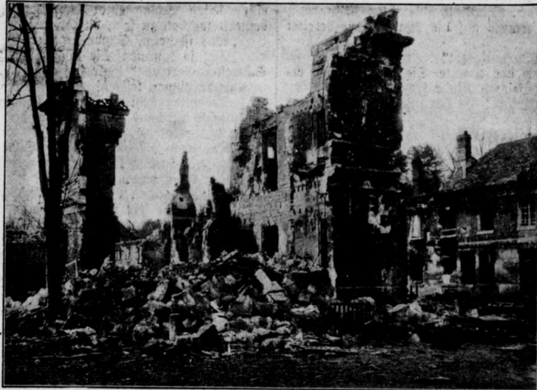
Vom westlichen Kriegsschauplatz: Eine durch Artilleriegeschosse vollständig zerstörte Fabrik. (Phot.: Oskar Zellmann, Schwetzingen.)
