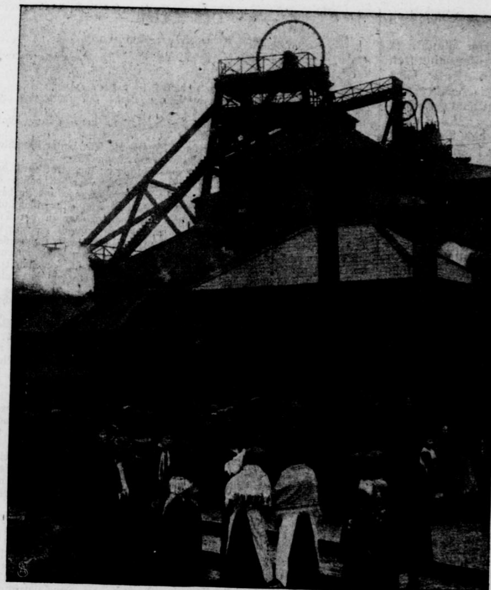
Von dem großen Grubenunglück bei Durham (England): Vor der Einfahrt zur Grube nach der Katastrophe.
