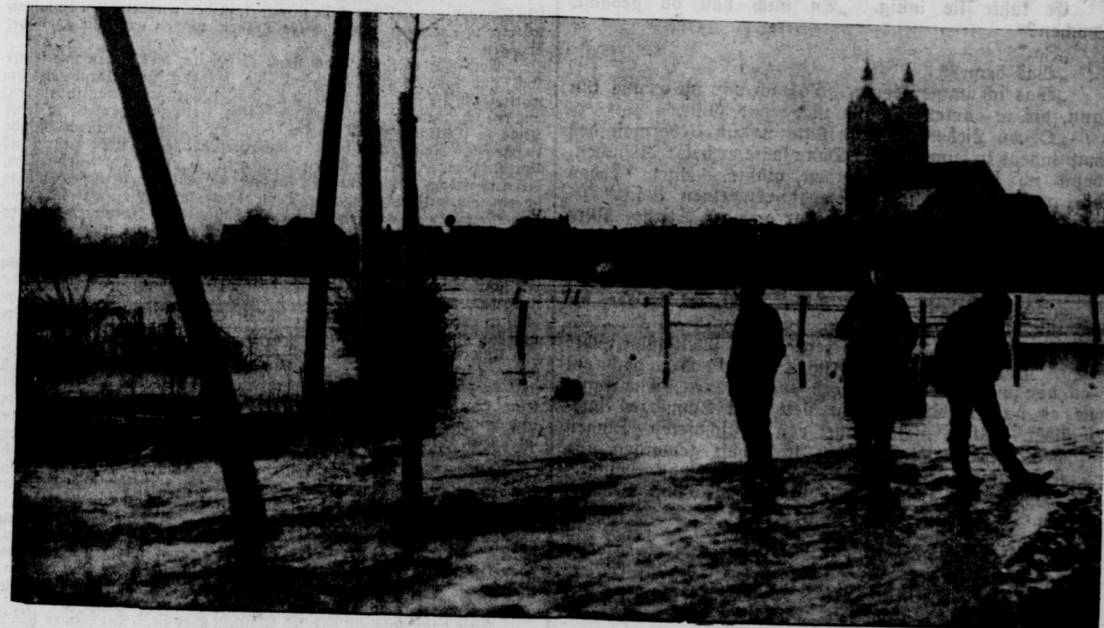
Eine durch das Hochwasser vollständig vom Verkehr abgeschnittene Stadt in der Altmark: Blick auf die überflutete Stadt Seehausen.
