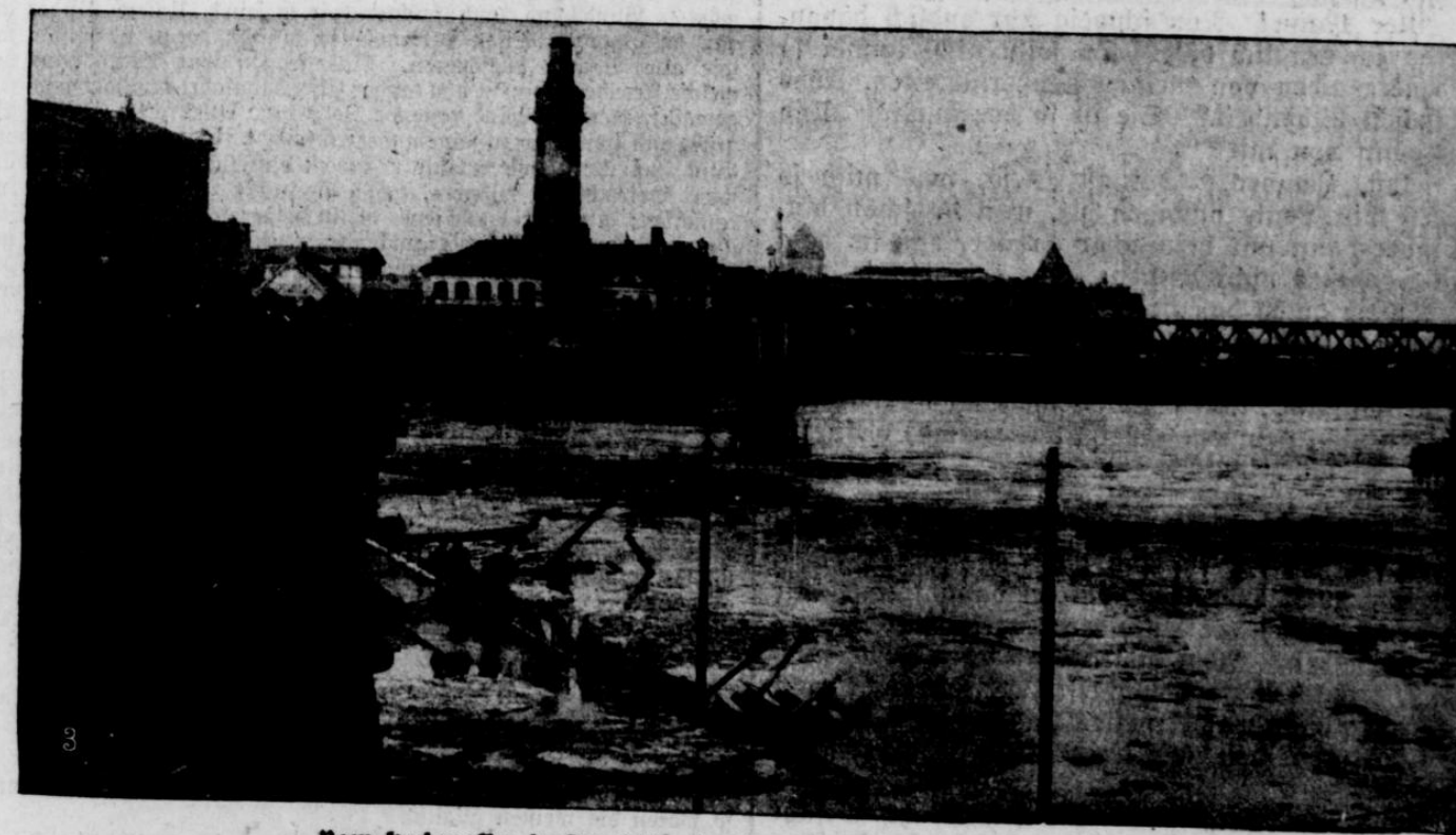
Vom Hochwasser in Deutschland während der ersten Februarwoche: Die für den Verkehr gesperrte Interimsbrücke über die Elbe in Dresden.
