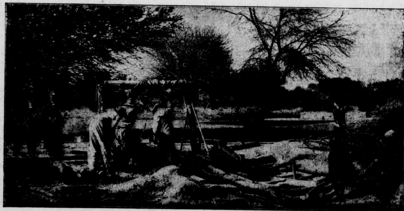
Bilder aus Deutsch-Südwestafrika: Beim Brunnenbau.
